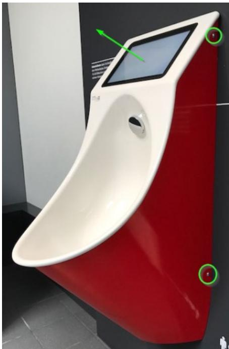
Demontieren Sie die Schürze, indem Sie die vier Schrauben lösen. Bitte beachten Sie, dass die Schürze nur mit diesen vier Schrauben fixiert ist. Sie müssen deshalb die Schürze beim Lösen der Schrauben festhalten.
