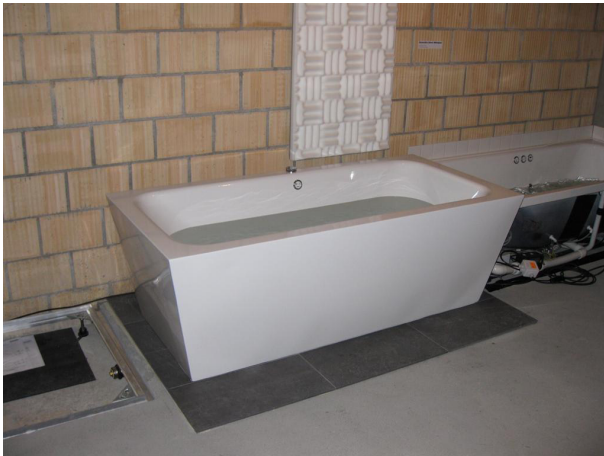
Abb. 1: Einbausituation im Anregungsraum
