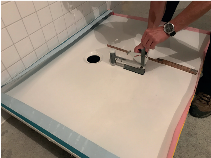
Abb. 1: Einbausituation im Anregungsraum
