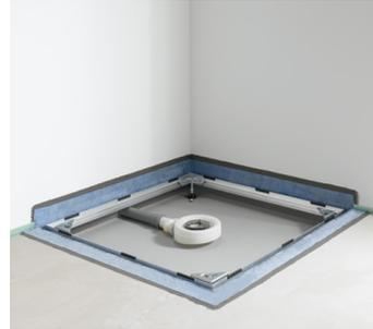
Das Abdichtungsvlies wird am Rahmen und an der Wand mit der zweikomponentigen Dichtungsmasse verklebt.
